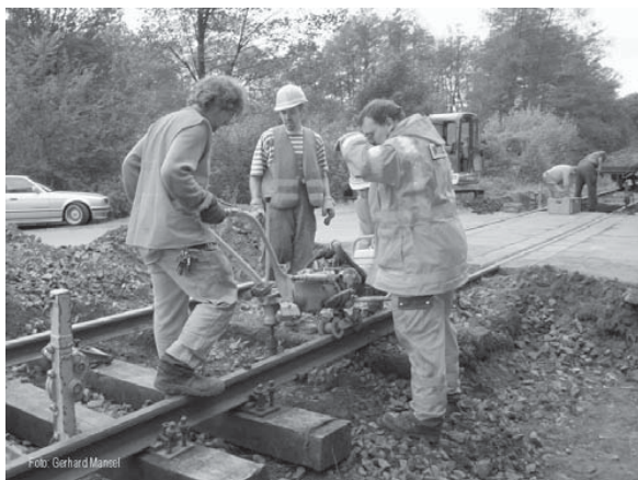
Reparaturtrupp bei der freiwilligen Arbeit
