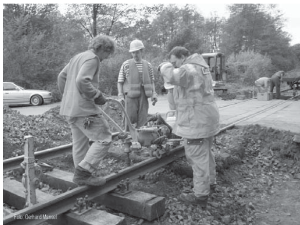
Reparaturtrupp bei der freiwilligen Arbeit
