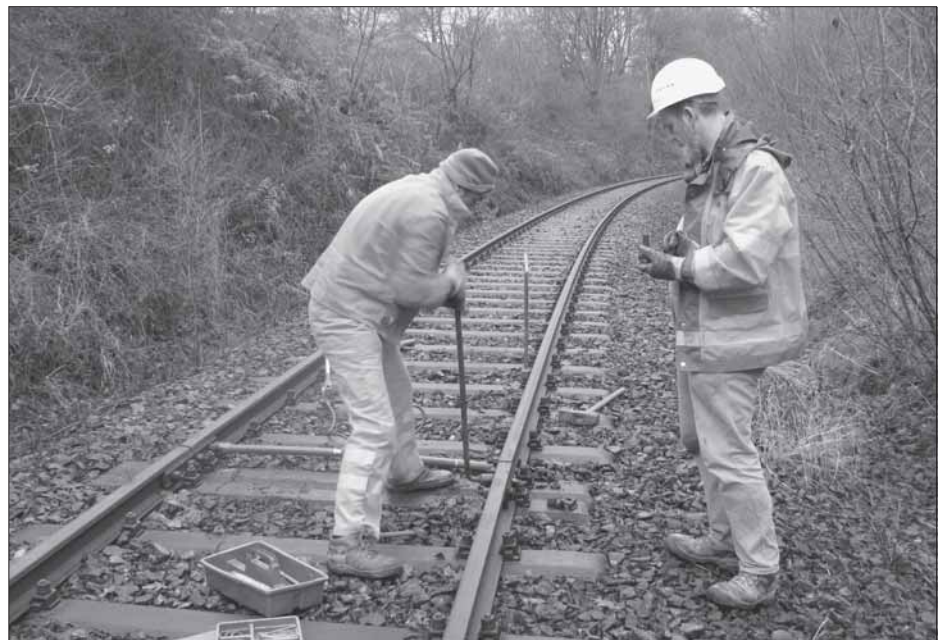
Das richten dutzender Schienenstöße auf dem „neuen“ Abschnitt gehörte zu den Arbeiten im vergangenen Jahr, hier bei Denklingen am 28.11.2009.
