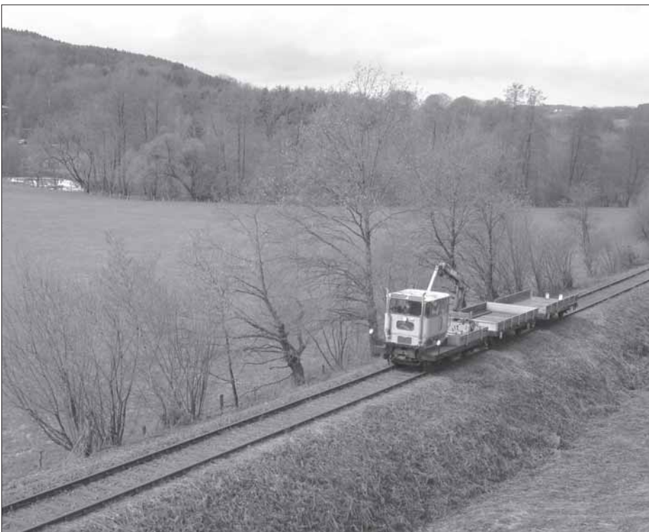
Vor wenigen Jahren standen zwischen Oberwiehl und Remperg-Mühlenau noch Bäume auf der Bahntrasse, nun wurde die 1,8 Kilometer lange Strecke wieder in Betrieb genommen. Bereits am 1.4.2006 war der Arbeitszug der Wiehltalbahnhof jenseits von Oberwiehl unterwegs.
