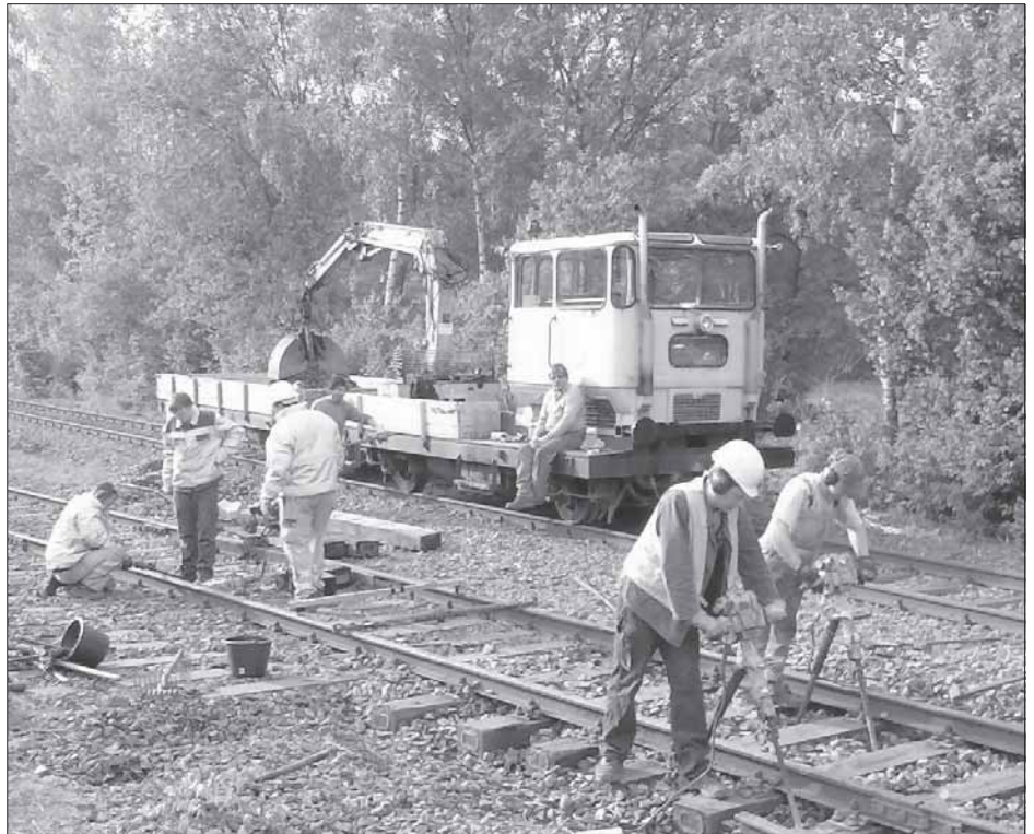
Dürfen weiterarbeiten und weiterhin fahren: Wiehltalbahner bei Gleisbauarbeiten.
